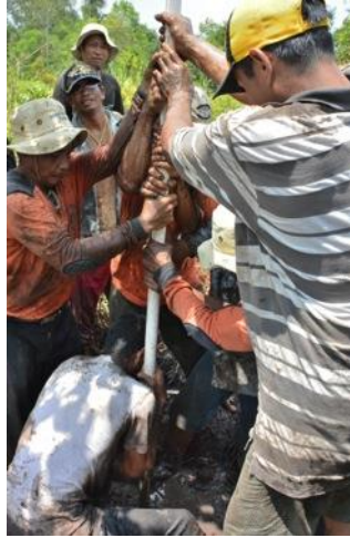
Gambar 18. Proses memasukkan pipa sesaat setelah pipa bor dicabut
