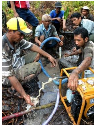
Gambar 19. Pemompaan air dari sumur bor untuk pertama kalinya
