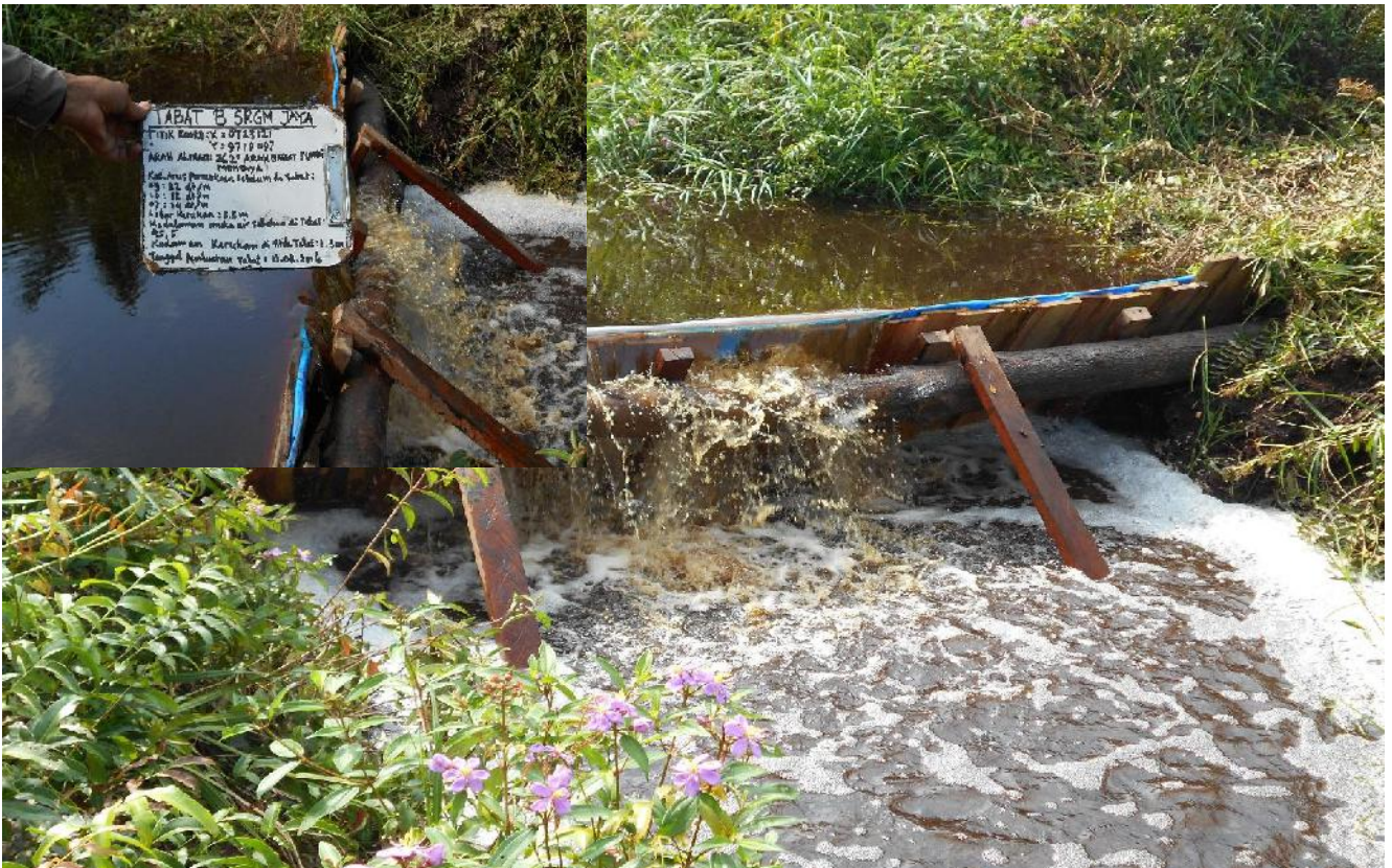
Figure 39. Pembuatan tabat di desa Seragam Jaya, Kalimantan Tengah
