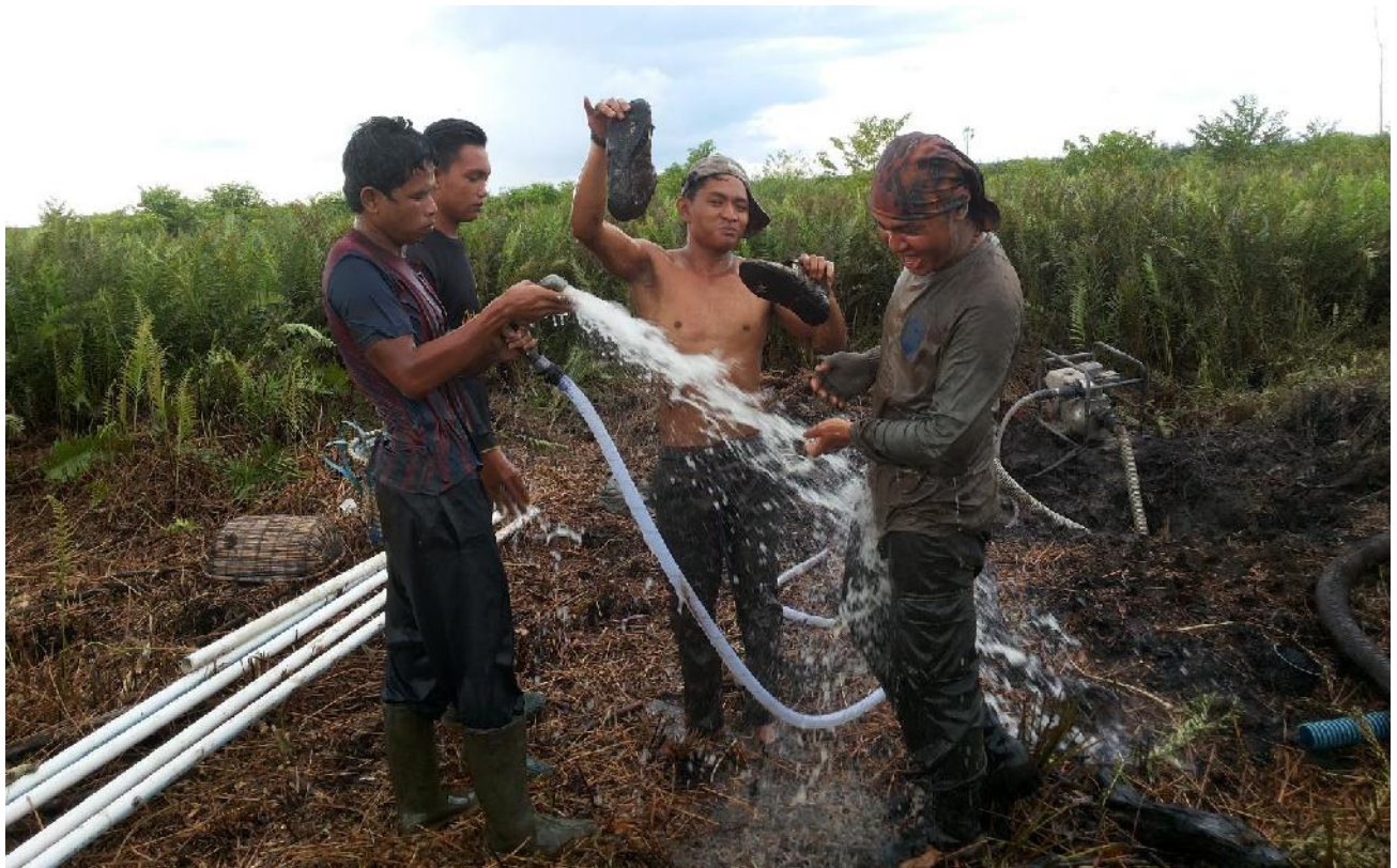
Figure 38. Pembuatan sumur bor dilokasi rawan terbakar di wilayah desa Hantipan, Kalimantan Tengah
